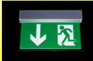
Abb. 42: Fluchtwegkennzeichnung elektrisch beleuchtet mit eigener Stromversorgung in der Überdachung am Kaiser-Josef-Platz (Abmessungen ca. mm [LxBxH] 344 x 44 x 240)
