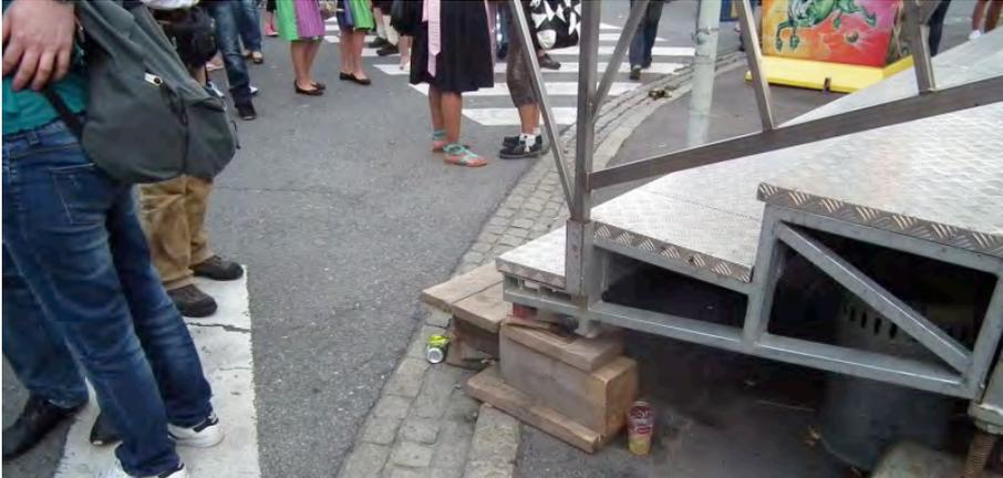
Abb. 52: Gefährlicher Stiegenvorsprung einer Anlage im Vergnügungsbe-
