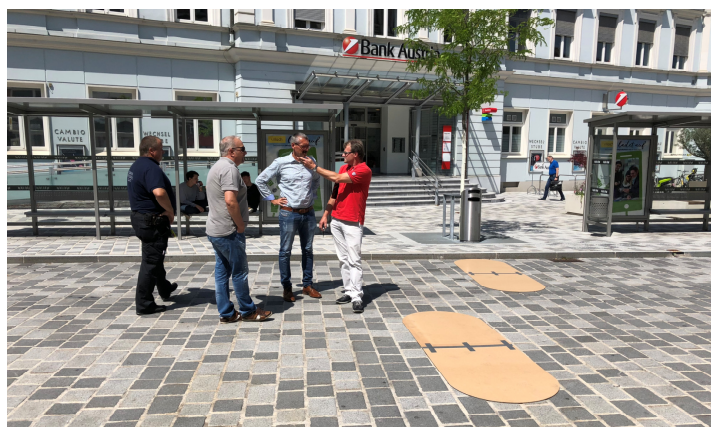
Abb. 11: Sperrelemente CitySafe Zufahrt Hans Gasser Platz von Westtangente
